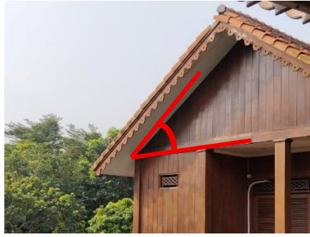
Gambar 4. Sudut Lancip pada Kemiringan Atap
