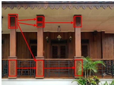
Gambar 7. Pola Pengulangan pada Tiang Rumah
