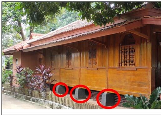
**Gambar 12. Prisma Segiempat pada Umpak**
