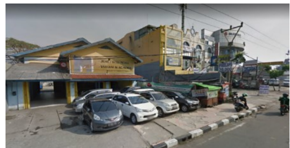
Gambar 6 Kondisi Trotoar Existing
