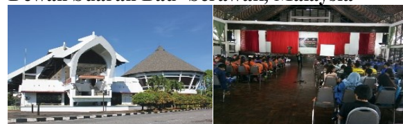
Gambar 1.2: Eksterior dan Interior Dewan Suarah Bau, Serawak, Malaysia
