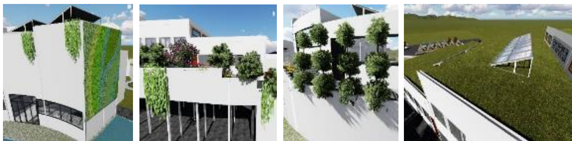
Gambar 15. Vegetasi pada Bangunan Quranic Learning Center
