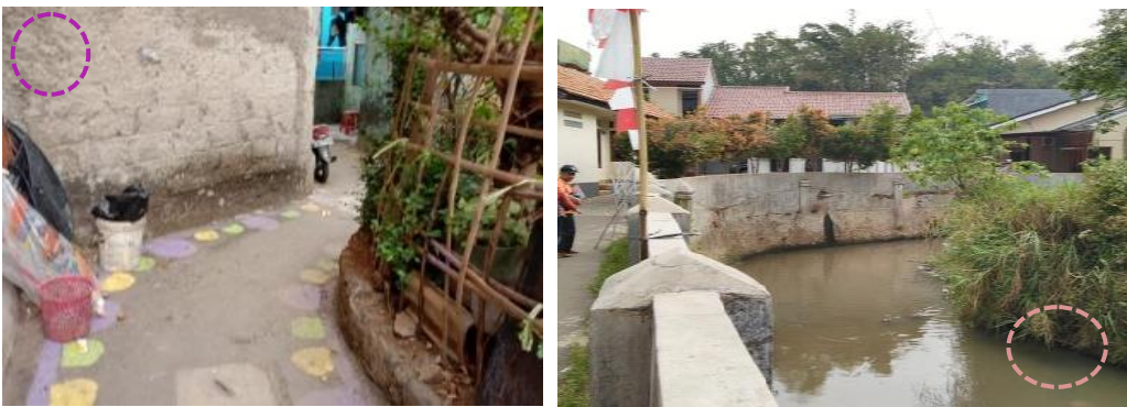
Gambar 7. Kondisi Jalan lingkungan sekunder permukiman yang belum ada pengembangan peningkatan lingkungan hidup seperti tanaman hidroponik
