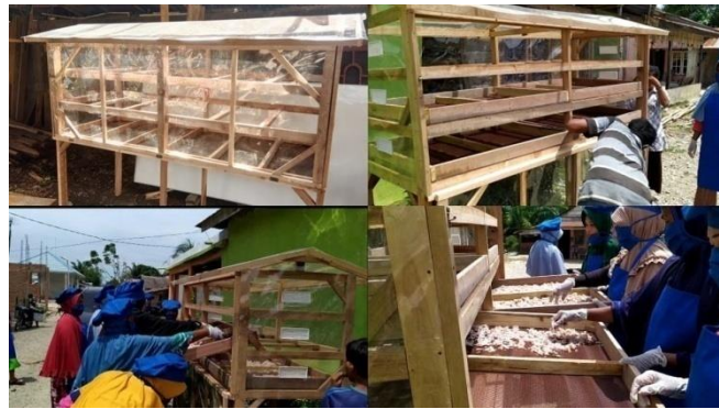
Gambar 4. Rumah pengering tenaga surya
